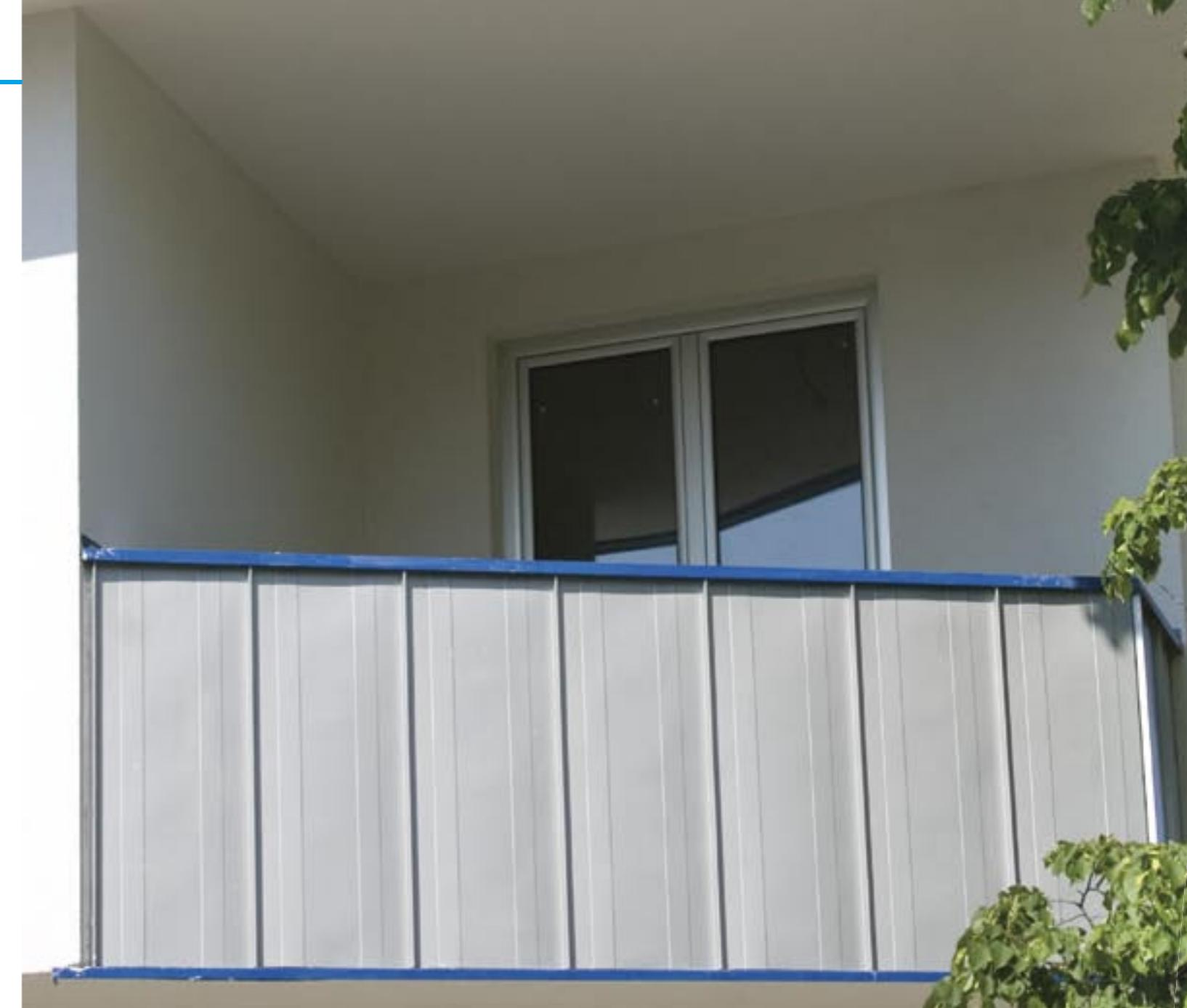
"Falco" samouklapajući lim posebno preporučujemo za unutrašnje fasadne površine atike na objektima sa skrivenim krovistem. U slučaju betonske atike kao podkonstrukcija će poslužiti drvena letva tiplana u zid atike, a kod metalnih atika obično iskoristimo glavnu metalnu konstrukciju uz eventualno dodavanje pojedinog profila.
