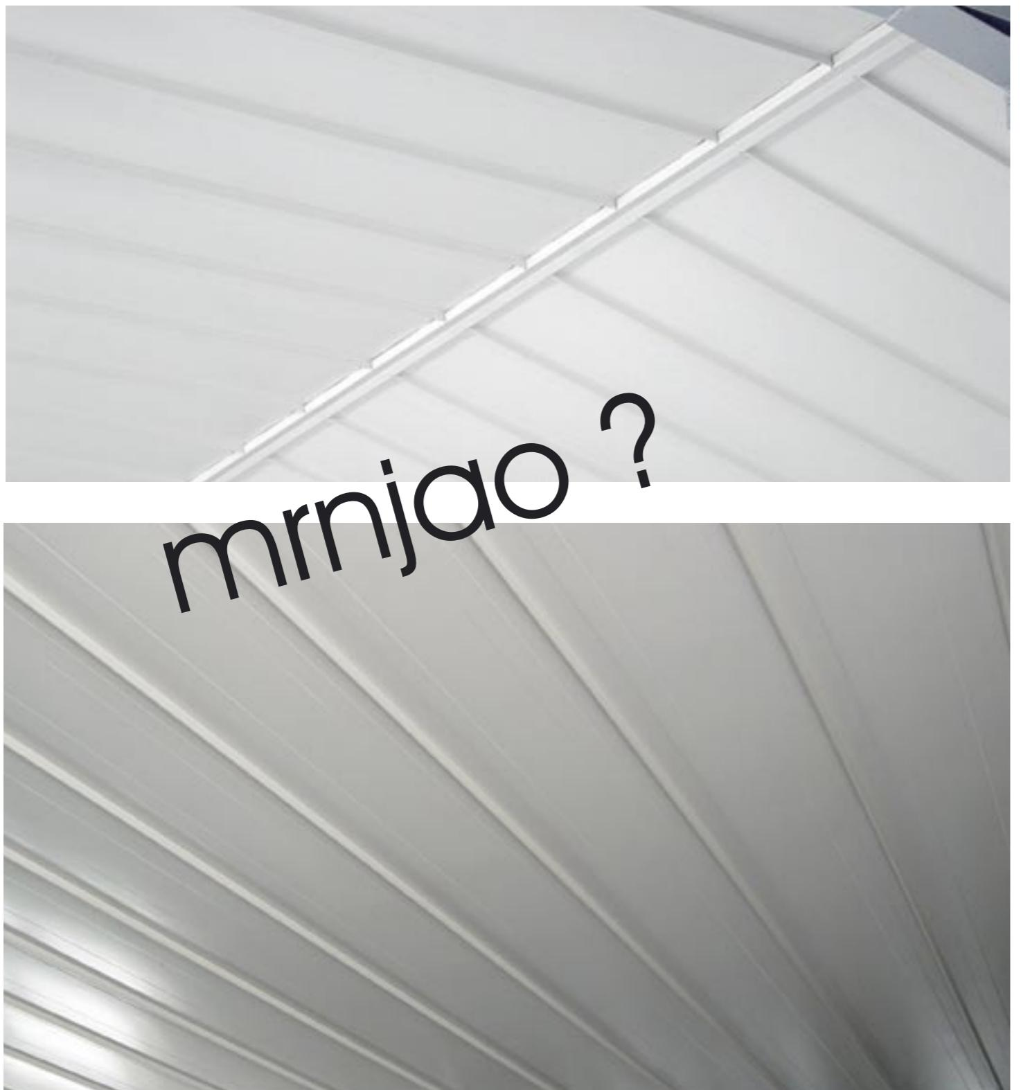
Za podkonstrukciju najčešće koristimo drvene letve na odstojanju cca 1,00-1,50 metar ili koristimo već postojeću konstrukciju stropa. Za spojni materijal kao kod krovnog i fasadnog lima koristimo rigips-vijak ili nitnu, ovisno o vrsti podkonstrukcije.
