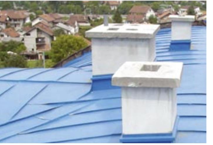
Prilikom montaže falcanog lima prvo se postavi "šarna", pored nje se postavljaju nosači na svakih cca 30 do 50 cm, zatim se postavlja susjedna "šarna". Potom se ušice nosača ručno saviju oko obje šarne. Nakon montiranja "šarni" vrši se duplo falcanje, ručno ili mašinski pomoću prenosne (terenske) maštine. Na falcane pokrove kao snjegobran preporučujemo isključivo linijski snjegobran sa šipkom i specijalnim držaćima koji se za falcani pokrov spajaju na mjestima falca bez bušenja lima.
